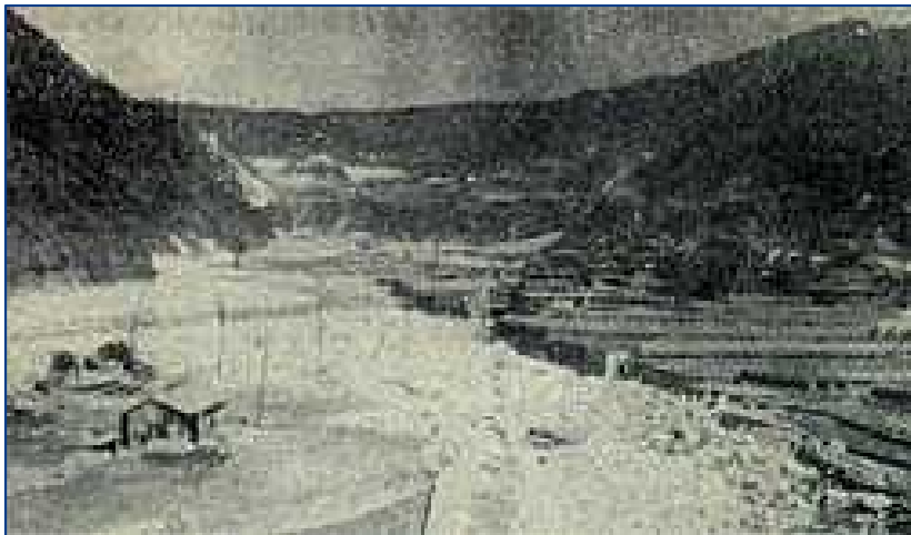
昭和20年9月 枕崎台風 黒瀬川の氾濫（建設省河川局治水課）
